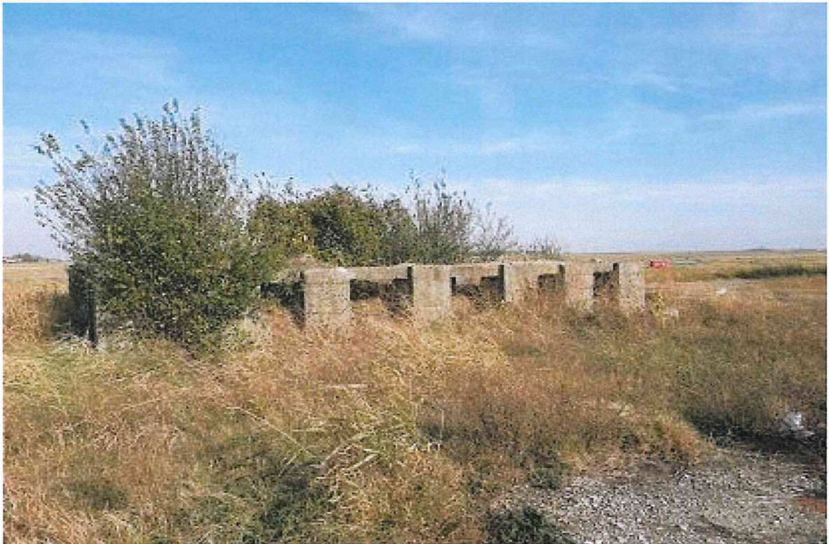
Слика армирано-бетонске конструкције коју је потребно уклонити
