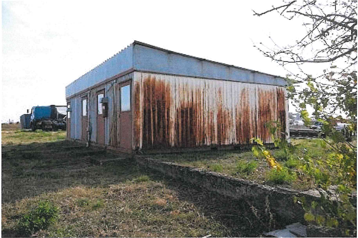
Објекат број 4 који се уклања
