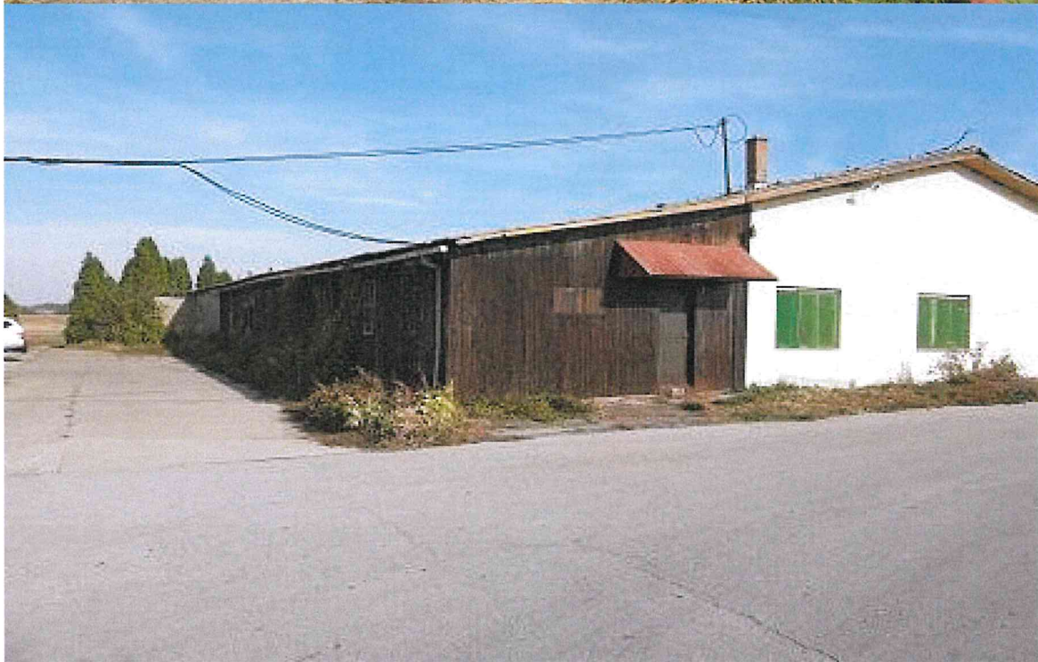
Објекти број 1а и 1б који се уклањају ( комбинација зиданог објекта и дела са дрвеном носећом конструкцијом
