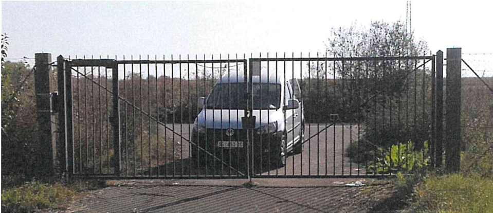
Сл. 6 Постојећа капија на огради око трафо станице
