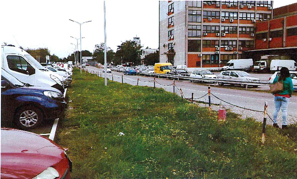
Сл. 3 Постојећа ограда око паркинга П7
